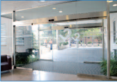
Entrada principal. Sistema de dos puertas automáticas correderas.
