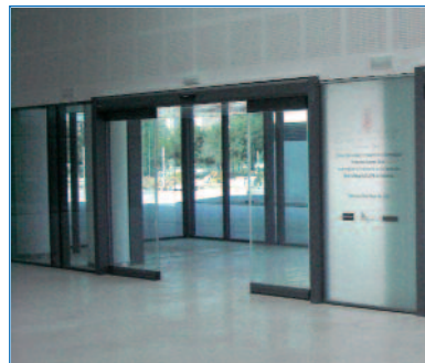
Entrada principal. Puertas automáticas con sistema antipánico integral.
