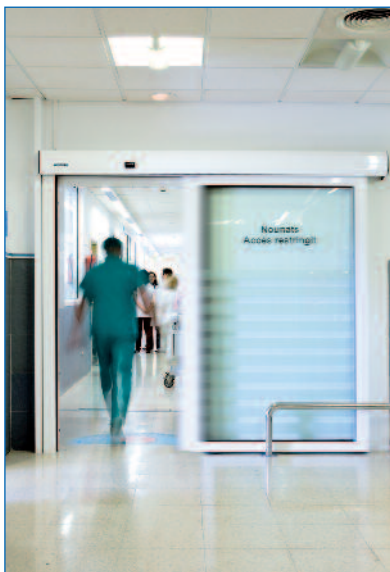
Sectorización de espacios. Puerta automática resistente al fuego.
