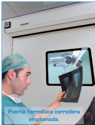
Aislamiento. Dos capas de plomo en la puerta solapan con el plomo de las paredes.
